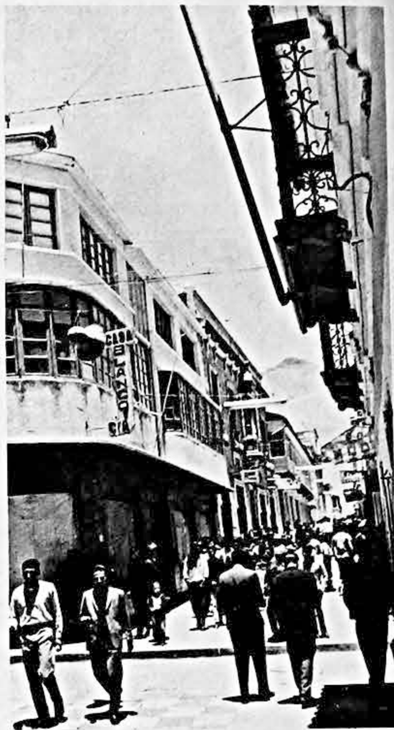
El "Boulevard", la principal calle comercial y de paseo en Potosí.
