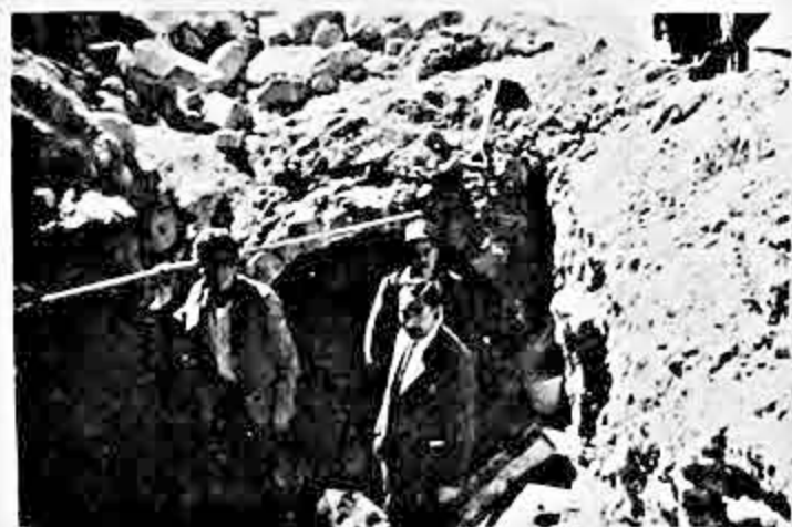
Canalización de la calle "La Paz", zona sur, efectuada por la Junta de Obras Públicas.
