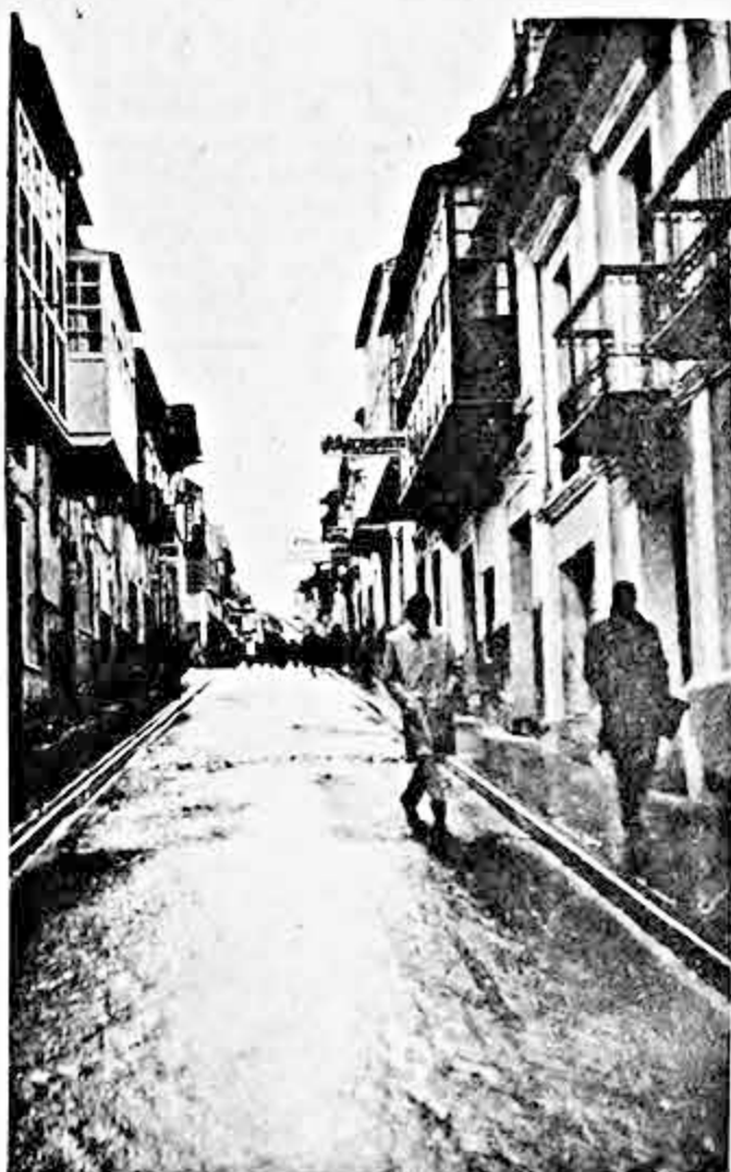
Calle "José María Linares", arteria céntrica cuya calzada ha sido pavimentada también por la Junta de Obras Públicas.
