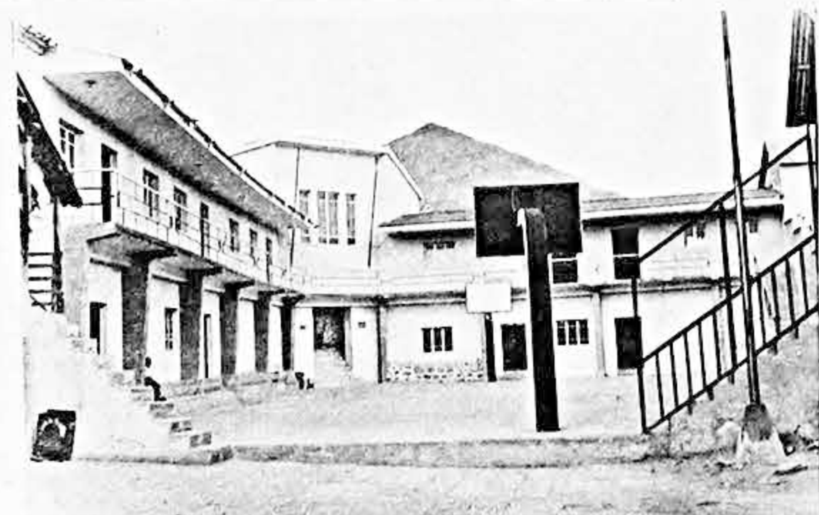
Esta es otra de las importantes obras construidas por la Junta Departamental de Obras Públicas de Potosí. Es el edificio ya concluido del Colegio Nacional "Juan Manuel Cabero", cuyas aulas
