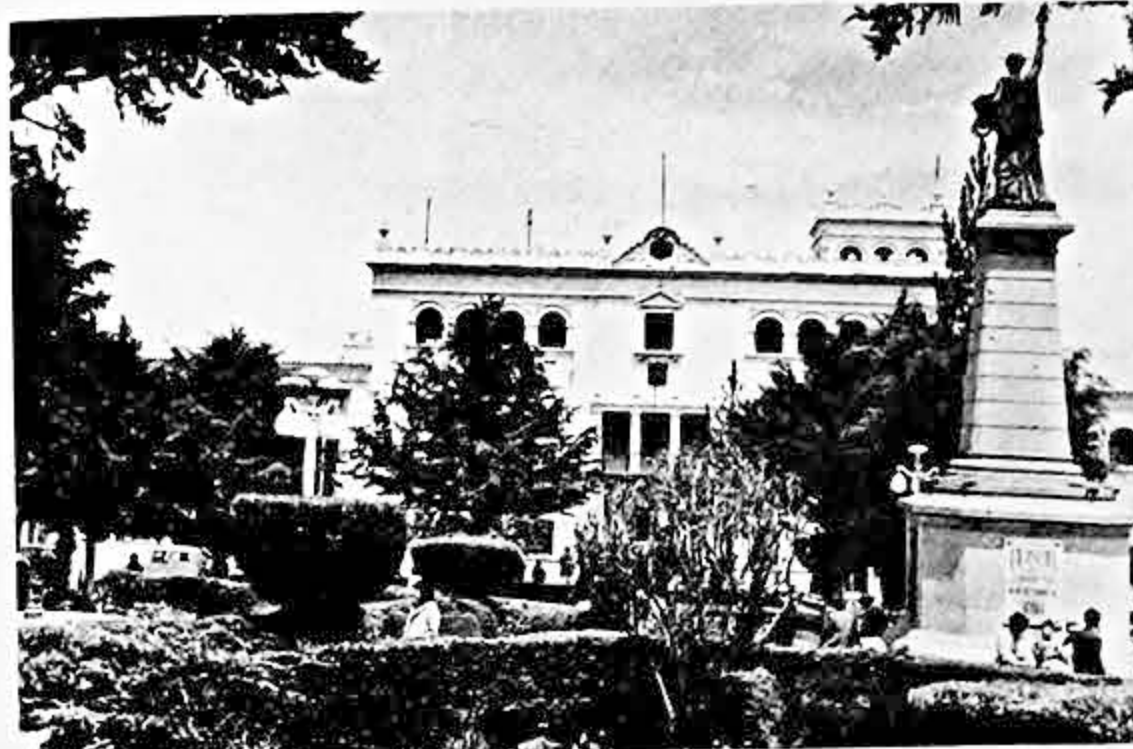
A los 4.000 metros de altura sobre el nivel del mar, la vegetación cultivada embellece la Plaza de "Noviembre" de Potosí. Al fondo aparece el Palacio Prefectural.
