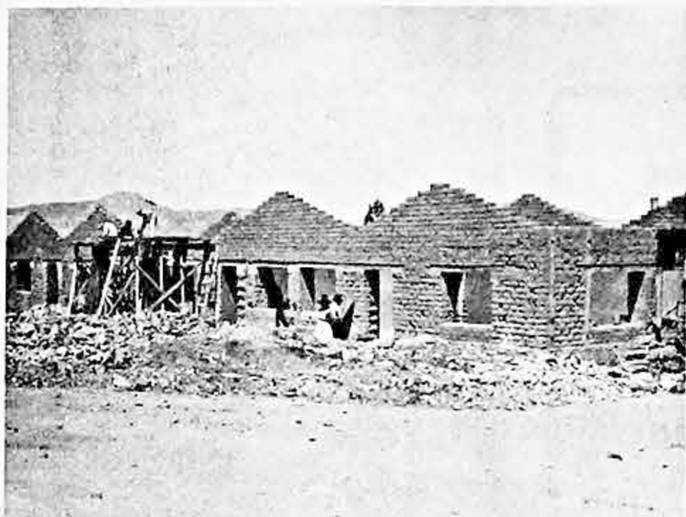
El edificio del Kindergarten "Potosí" cuando estaba en plena construcción.
