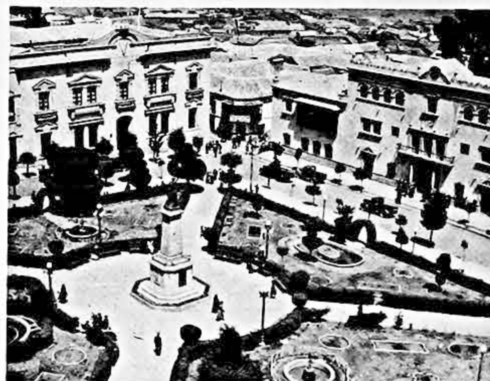
La Casa Prefectural de Potosí, que en el gráfico está a la izquierda, fue reconstruida no hace mucho tiempo. Ella era la residencia ordinaria del Cabildo que regía la Villa Imperial. Comenzó su construcción en 1572 por orden y a presencia del Virrey don Francisco de Toledo y terminó en 1648.
