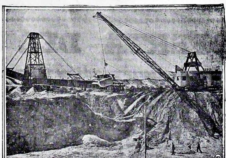
La foto muestra un aspecto de los trabajos que se están realizando para abrir un canal en el Norte del estado de Florida. La obra requerirá la excavación de 500 millones de metros cúbicos, o sea aproximadamente el doble del volumen de tierra excavado en el Canal de Panamá.
