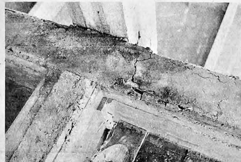
El deterioro de las instalaciones del Terminal del nuevo aeropuerto puede apreciarse en la nota gráfica. Las estructuras se están agrietando.
