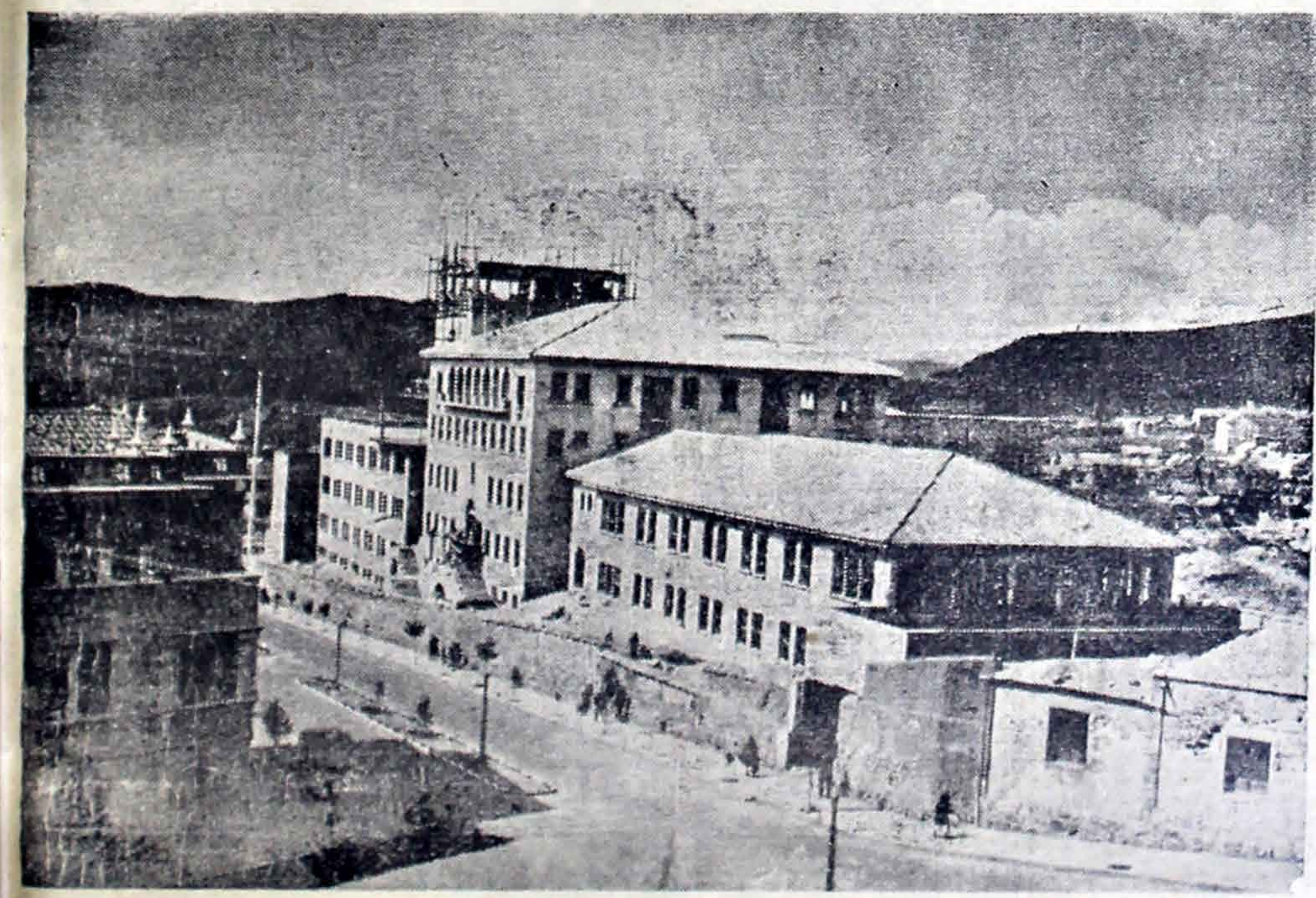
EDIFICIO EN CONSTRUCCION DE LA UNIVERSIDAD "TOMAS FRIAS" DE POTOSI
