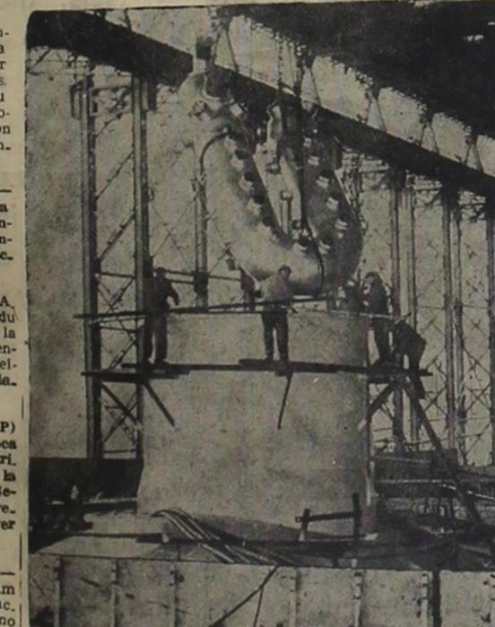
BUQUE NUCLEAR.— Instalación de un núcleo para el buque nuclear Savannah, al sistema de reacción nuclear. En este buque se instalaron más de cuatro mil toneladas de equipos nucleares. En este mes de julio el buque será sometido a pruebas.
