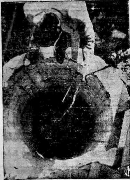
PARA LA COLOCACION DE PILOTES, CON DESTINO A LAS fundaciones del dique del río de La Florida, ha sido construido este profundo pozo de concreto armado.
