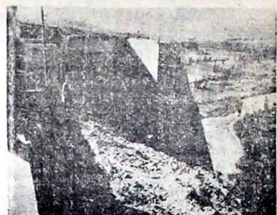
UNA VISTA DEL MURO DE CONTENCIÓN DE LA ANGSTURA, CUYA PARTE LATERAL CEDIÓ, SEGÚN INFORMES TÉCNICOS, POR LA DEFICIENCIA DEL TRABAJO Y POR MALOS MATERIALES EMPLEADOS EN SU CONSTRUCCIÓN.
