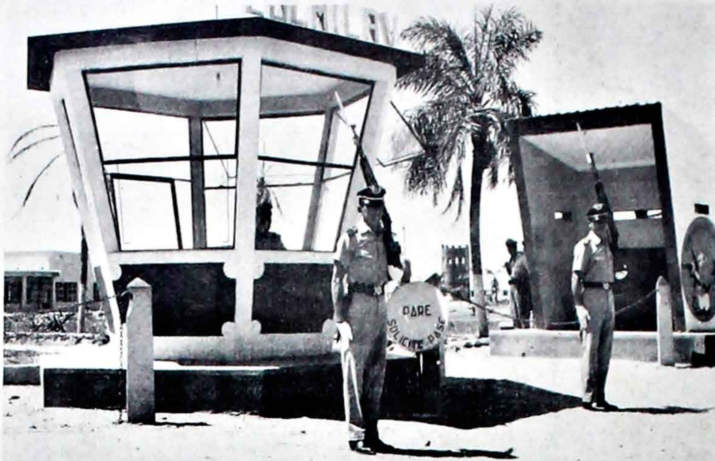
La modernización de las dependencias del Instituto Militar de Aviación de Santa Cruz se realiza en forma acelerada desde enero del año en curso. La fotografía muestra la puerta de ingreso a dicha dependencia militar, construida a base de cemento armado con un costo de doce mil pesos bolivianos. Desde su fundación, ocurrida hace trece años, durante la Junta Militar del Gral Hugo Ballivián, este instituto no contó con una portada como la presente.
