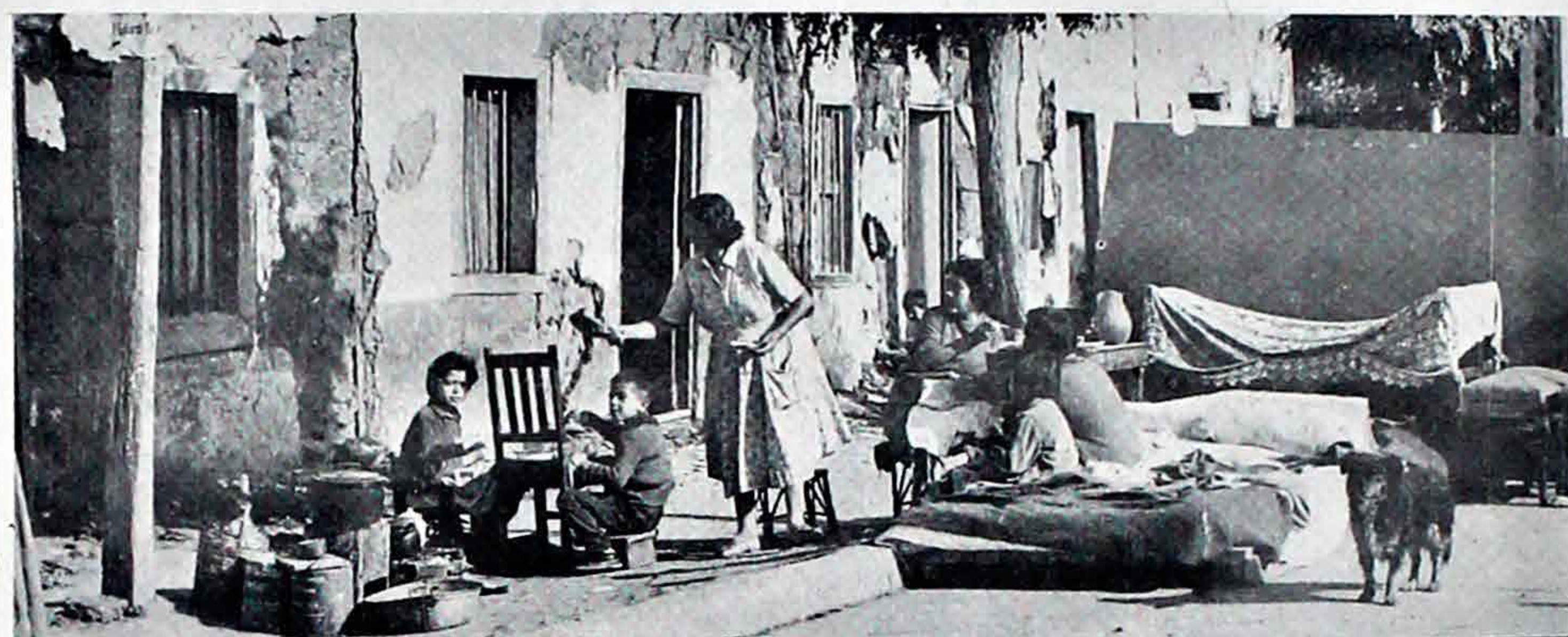
Las calles del pueblo de Llay Llay estuvieron atestadas de familias que, al iniciarse el temblor, abandonaron sus viviendas presas de pánico para protegerse de los derrumbes. Muchas perdieron sus casas y tuvieron que acomodarse en plena vía pública.
