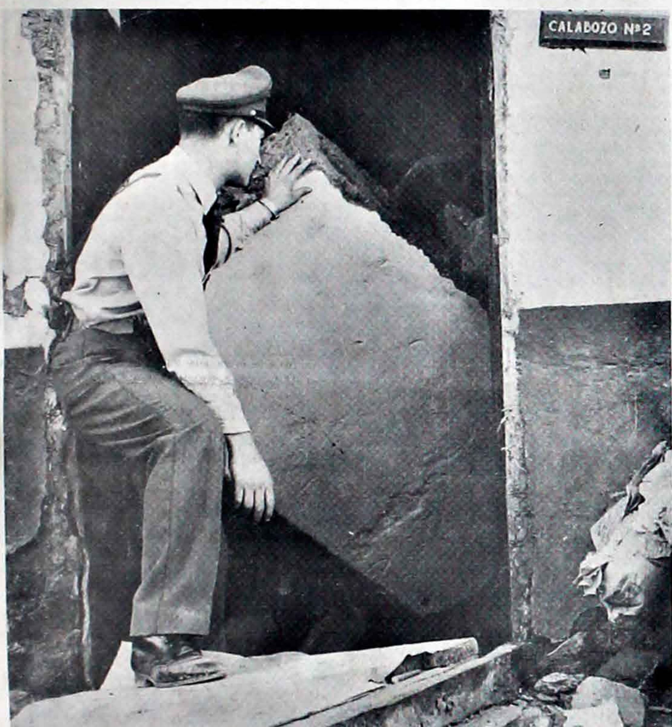
Ni las cárceles se libraron de la violencia del sismo. Aquí un policía observa toda una pared de un calabozo, que se derrumbó. Los reos, sin embargo, mantuvieron firme su palabra de honor empeñada en la penitenciaría, de no abandonar el edificio.
