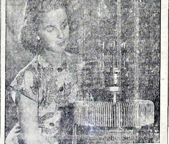
NUEVA YORK (SIPA).— Esta válvula transmisora de radio de 25.000 vatios ha perdido más de 57 kilos de peso mediante un "tratamiento para reducir", consistente en la sustitución del sistema enfriador de cobre por un radiador construido en el laboratorio.
