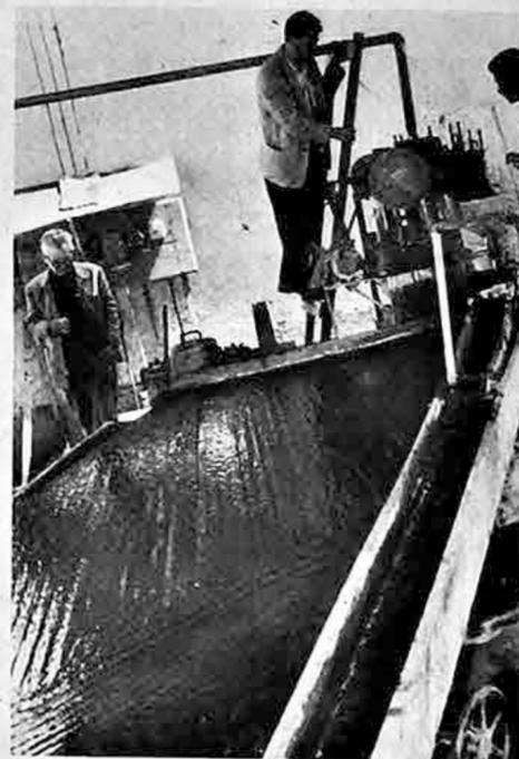
La Sección de Concentrados de Escorias de la Fundición "METABOL", servirá para recuperar los residuos metálicos, que aun, después de ser tratados, arrastran partículas metálicas que anteriormente se votaban al desmonte. A tal fin, se está instalando mesas concentradoras. El Ing. José Miguel de Velasco en compañía del Ing. Gerardo Thoferh, en la fotografía, aprecia el trabajo que cumple una de las mesas instaladas.
