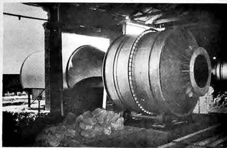
Este horno rotativo diseñado por el Ing. Gerardo Thoferh y construido íntegramente por los técnicos y trabajadores de la Fundición "METABOL", fundirá 180 toneladas métricas finas al mes. En base a la capacidad y esfuerzo desplegado se está ahorrando 35.000 dólares. Su costo, aproximadamente, asciende a 10.000 dólares. El importarlo costaría más de 45.000 dólares. Se instalarán 3 hornos similares a este.
