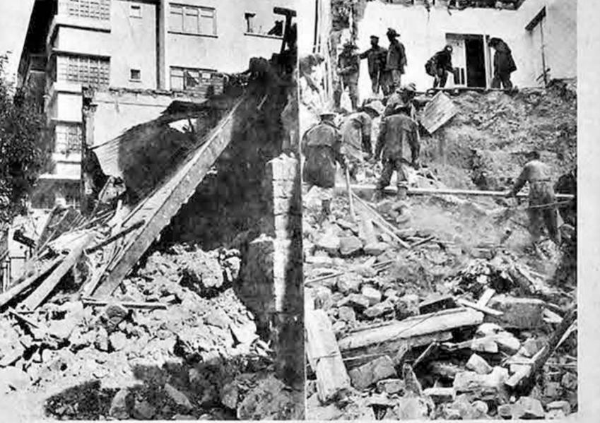
Dos vistas del estado en que quedó el inmueble de la avenida Ecuador que se derrumbó ayer debido a unas excavaciones que se realizaban en su parte inferior para construir dos almacenes. Las excavaciones debilitaron los cimientos dejándolos sin ningún soporte lo que ocasionó que la construcción se viniera abajo con gran estruendo.
