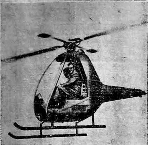
UN PILOTO DE PRUEBA APARECE PROBANDO EL NUEVO helicóptero de retropropulsión del ejército norteamericano...
