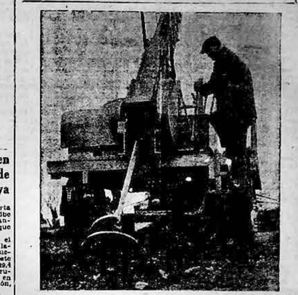
Esta nueva máquina perforadora, diseñada originalmen- te por el Laboratorio de In- vestigación de Carreteras (del Departamento de Investiga- ción Científica e Industrial) para exploración de tendido de carreteras, ha sido adaptado por una firma de ingeniería británica para uso de contra- listas de obras y de ingeniería civil.
