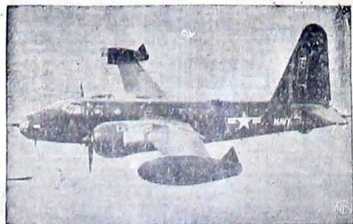
LA ULTIMA SOLUCION DE LA MARINA NORTEAMERICANA a cualquier posible amenaza submarina aparece haciendo su primer vuelo desde Burbank, California. Este avión Lockheed P2V-6 contiene unos motores de turbo compuestos para viajes de larga distancia, alta velocidad y corto despegue. El avión fue diseñado para colocar minas, bombardear de noche o a bajo nivel así como para lanzar sus bombas a alta altura y realizar misiones de reconocimiento.
