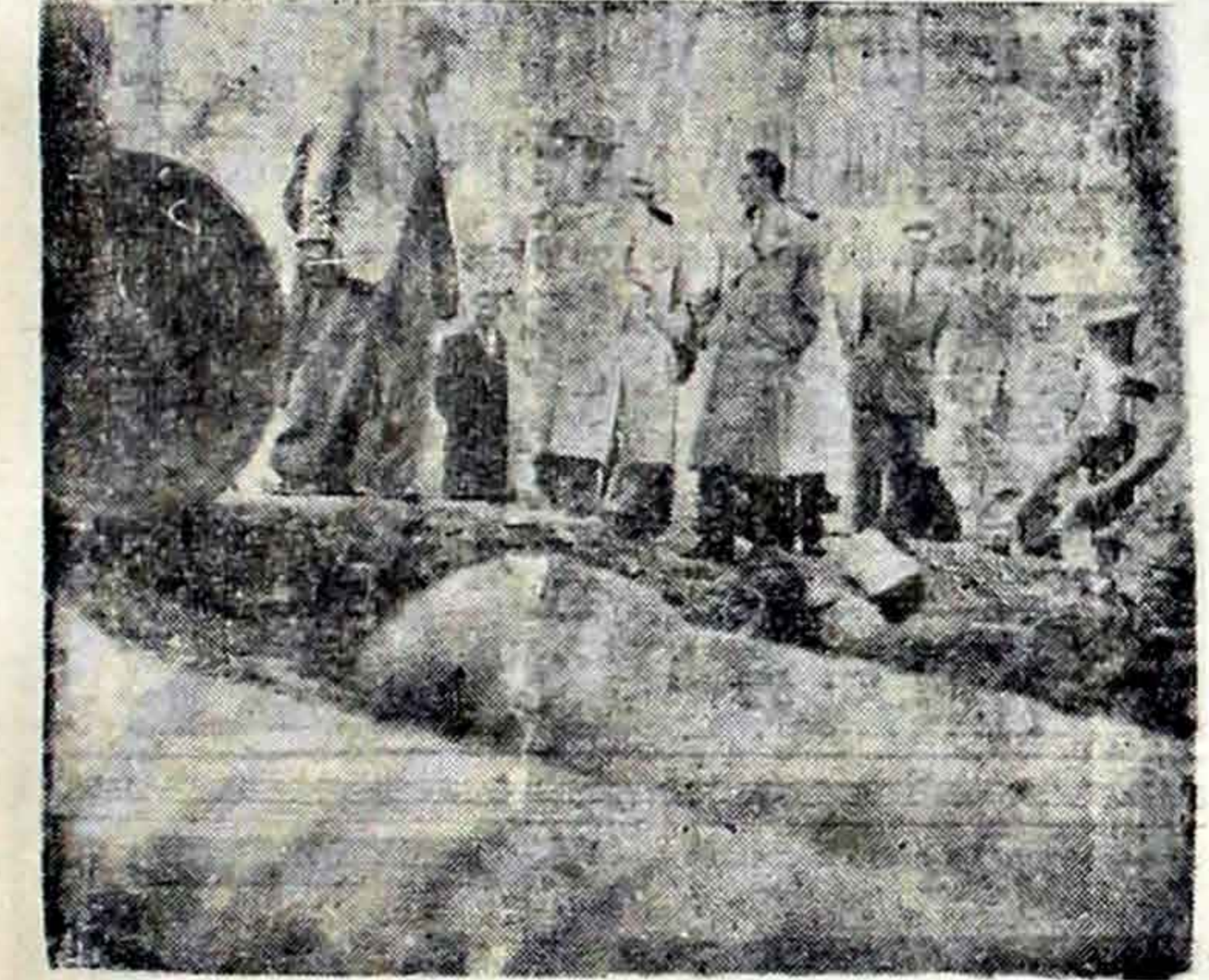
EL SR. ALCALDE Y SUS ASESORES TECNICOS, EN LA INSPECCION A LOS TRABAJOS DE ENTUBAMIENTO Y ALCANTRILLADO EN LA ZONA LA FLORIDA.
