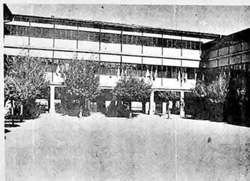
Un patio pavimentado y limpio y aulas amplias y llenas de luz, constituyen un ambiente adecuado para la recreación y estudio de las alumnas.
