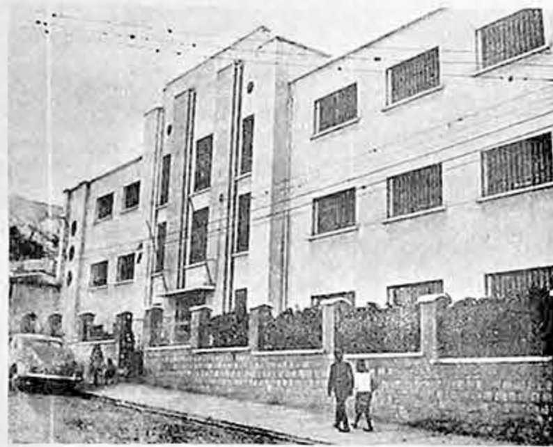
Esta es la fachada del Colegio María Auxiliadora donde reciben educación centenares de alumnas.
