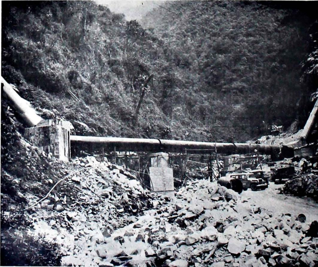
La presente fotografía muestra el montaje de la cañería para el sifón, como puede notarse es un trabajo de gran esfuerzo y precisión.
