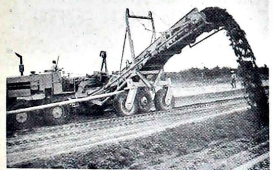
Una motoelevadora en pleno trabajo. Se trata de un equipo accionado por tractor y una correa transportadora. Con toda facilidad a medida que avanza la máquina saca la tierra de un lado y la transporta al centro de la vía. Este trabajo tiene que realizarse cuando la tierra tiene un cierto grado de humedad.
