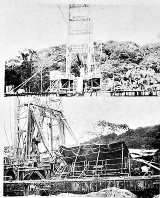
Arriba.- La flecha señala el escape de gas que aún continúa ardiendo en el Pozo N° 5 de Naranjillos; puede observarse, además, las tuberías dobladas por efecto del calentamiento. Abajo: una vista de los deterioros causados por el incendio.
