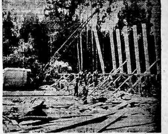
GIGANTESCOS PILOTES DE CONCRETO ARMADO SON COLOCADOS EN EL LECHO DEL RIO DE "LA FLORIDA", PARA LA CONSTRUCCION DE UN VERTEDERO. LOS TRABAJOS ESTÁN A CARGO DE LA EMPRESA ALMARAZ.—
