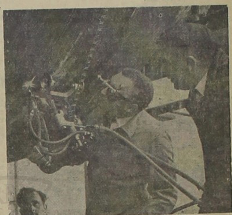
PEQUEÑA MAQUINA DE OXICORTE EN CENTRAL NUCLEAR. — En la central electro-nuclear de Trawsfynydd, al Norte de Gales, las cofias de un cambiador de calor de acero —de 5m. de diámetro y unos 6.5 cm. de espesor—, son fresadas a bisel con una máquina oxicortadora y biselada de tubos. La máquina se emplea normalmente para cortar tubos de hasta 90 cm. de diámetro.
