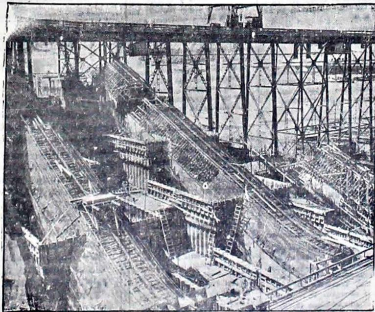
Las gigantescas compuertas a través de las cuales atemperará el agua a las turbinas de la usina eléctrica de la represa Gran Coocles con la que se dominarán las corrientes del río Coocles.
