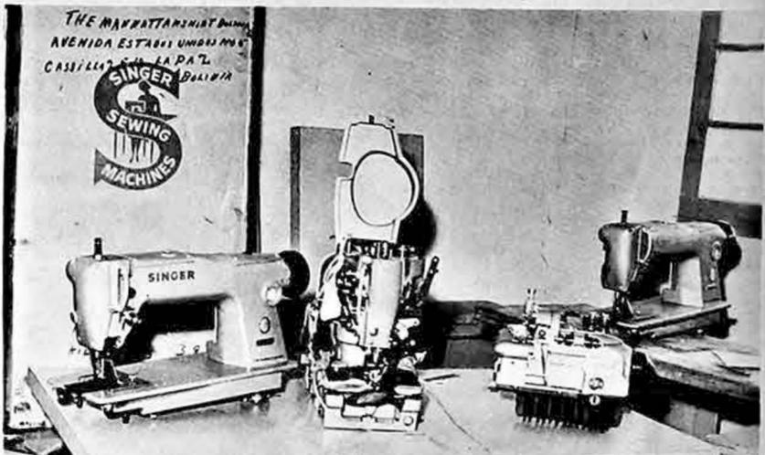
Una parte de la serie de máquinas de alta especialidad para la fabricación de camisas, importadas de los EE.UU. El montaje de la maquinaria es estrictamente vigilado por técnicos especializados en este tipo de máquinas.
